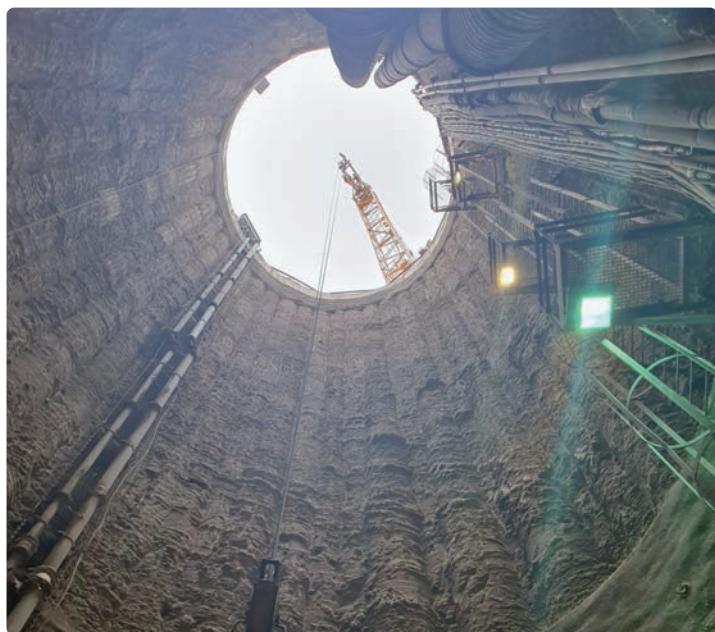
Pohled z útrob šachty nahoru na „světlo“.
