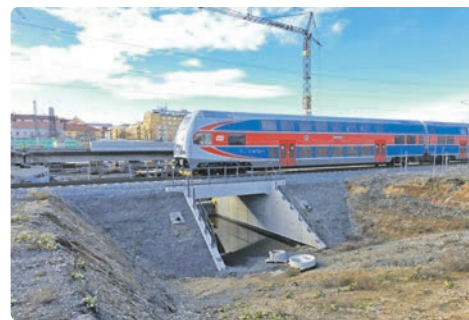
Prostup pod provizorní kolejí kralupské trati
