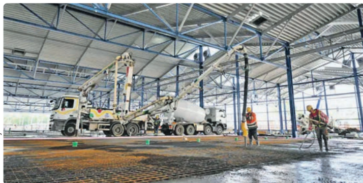
První rok výstavby vozovny Hloubětín
