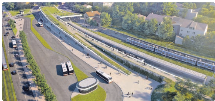
Foto: Správa železnic
