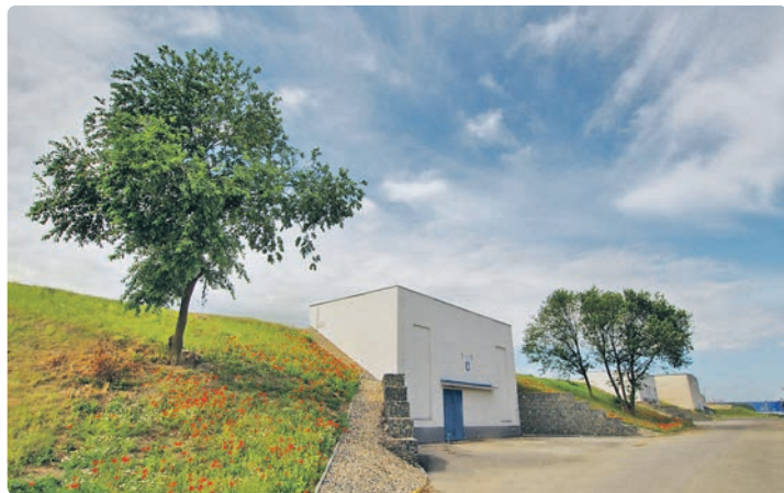
Vodojem Kopanina v Praze 6
