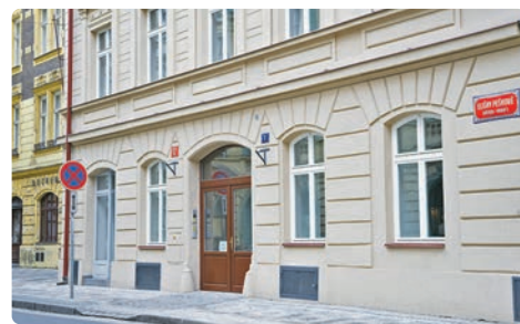
Dům po rekonstrukci v ulici Elišky Peškové září novotou
