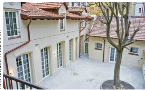
Nově zrekonstruovaný dvůr, sál a zázemí pro účastníky
