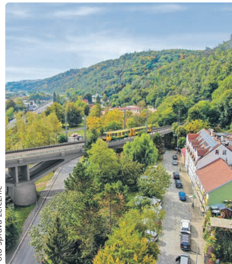
Foto Správa železnic
