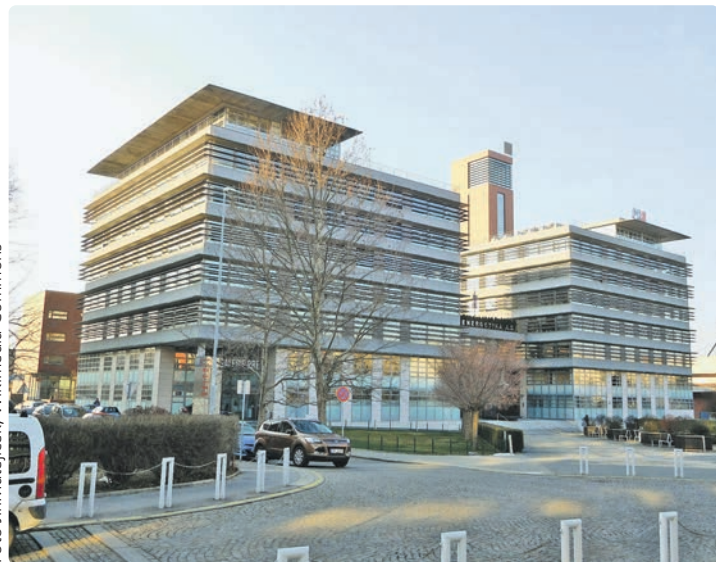
Sídlo společnosti PRE v ulici Na Hroudě v Praze 10
