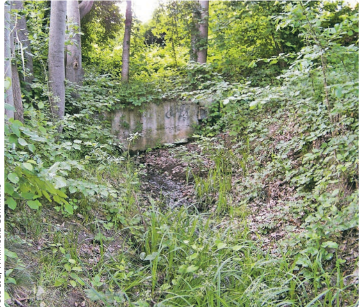
Zátišský potok mezi lhoteckým koupalištěm a rybníkem U Vodotoku
