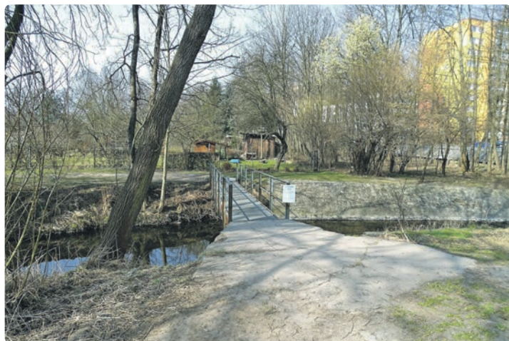
Záběhlice, lávka přes Botič u zahrádkářské kolonie v Trojmezí v roce 2015
