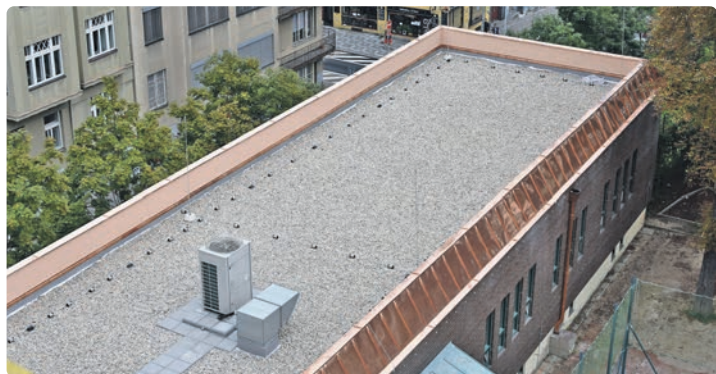
ZŠ Fr. Plamínkové – zrekonstruovaná střecha jídelny
