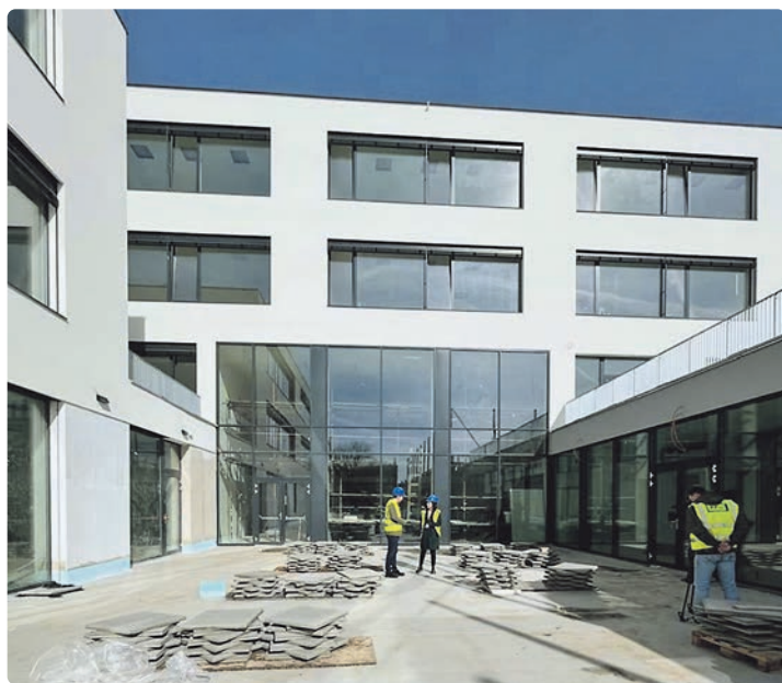
Výstavba základní a mateřské školy Elektra
