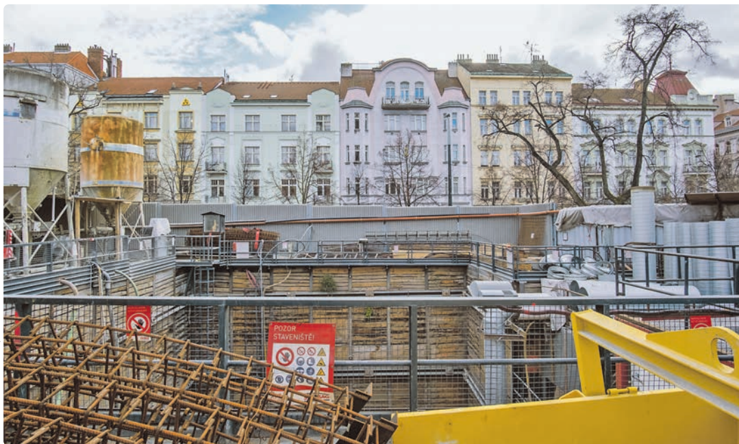
Dělníci zatím vyhloubili padesát výškových metrů.
