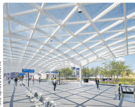
Foto Správa železnic
