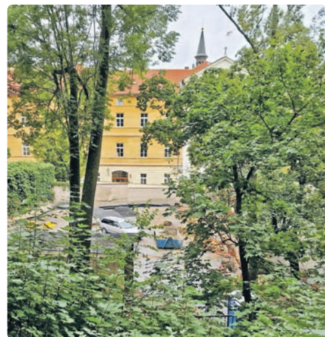
Na hřišti pod Petřínem jsou práce v plném proudu.
