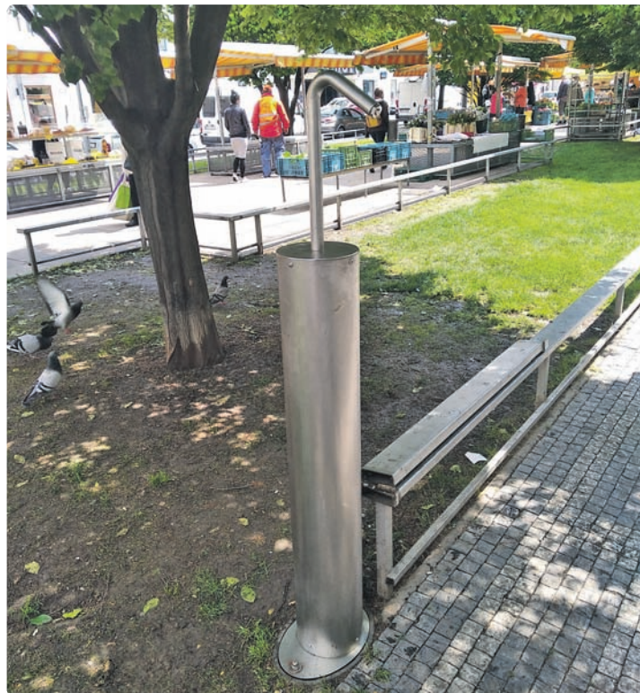
Městská část obnovila provoz mlžítok typu „brčko“. Jedno z nich je na Tylově náměstí.
