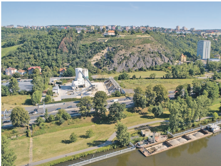
Betonárna Libeň (Troja) s lodním zásobováním a podzemním kolektorem pro transport kameniva od řeky do areálu betonárny.
