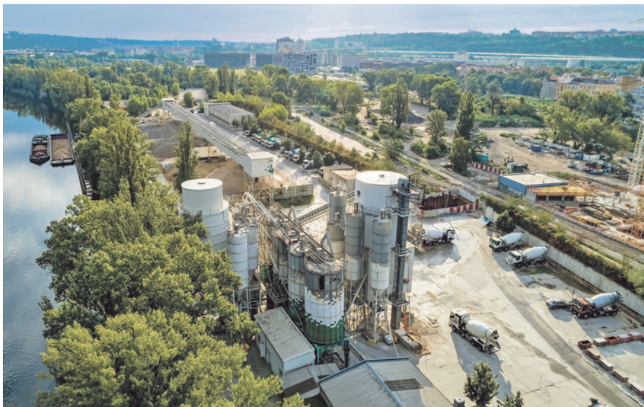
Betonárna Rohanský ostrov – lodní zásobování kamenivem, rozvoje lokalita.
