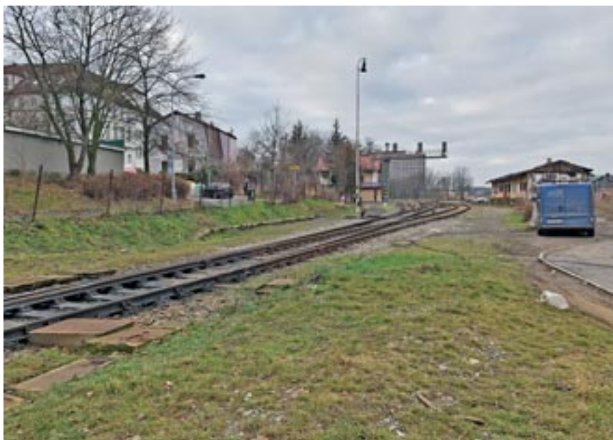
Stávající úsek trati Dejvice–Veveřín
